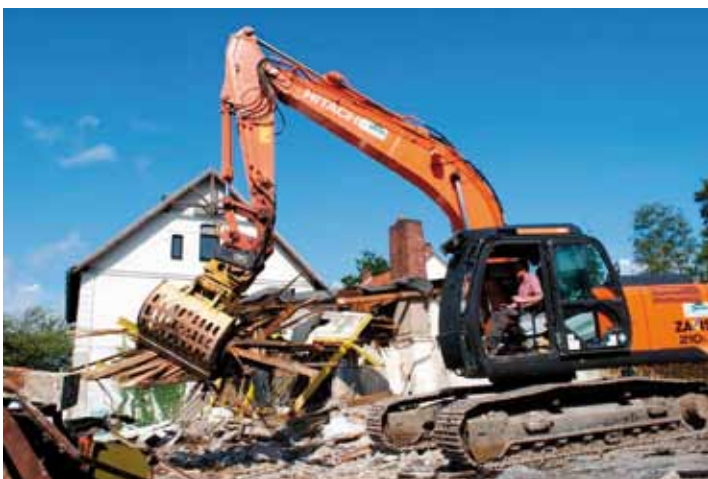
Auf dem Grundstück der ehemaligen Tankstelle wird die HBI drei Stadtvillen errichten.
